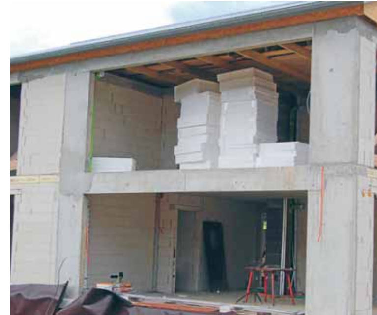
Nicht nur gutes Dämmen ist beim energieeffizienten Bauen wichtig. Auch auf Details kommt es an: Architekt Michael Birnthal deutet auf die Vordach-Konstruktion beim gemauerten Neubau-Haus – eine Dämmstoffschicht verhindert Kältebrücken. Fotos: hu
