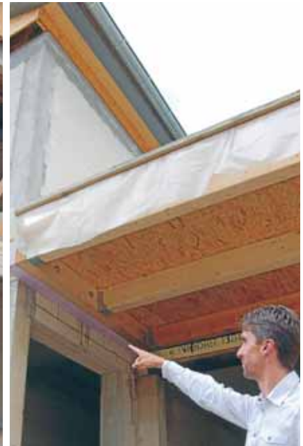
Nicht nur gutes Dämmen ist beim energieeffizienten Bauen wichtig. Auch auf Details kommt es an: Architekt Michael Birnthal deutet auf die Vordach-Konstruktion beim gemauerten Neubau-Haus – eine Dämmstoffschicht verhindert Kältebrücken. Fotos: hu
