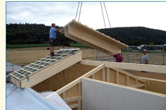
An nur einem einzigen Tag wurde das Passivhaus regendicht montiert
